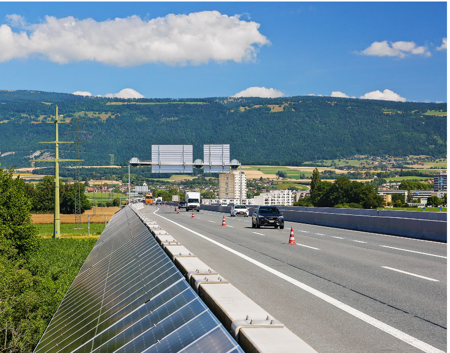
Die Solarpanels beim Viadukt von Yverdon werden jährlich 1,17 GWh Strom produzieren.
